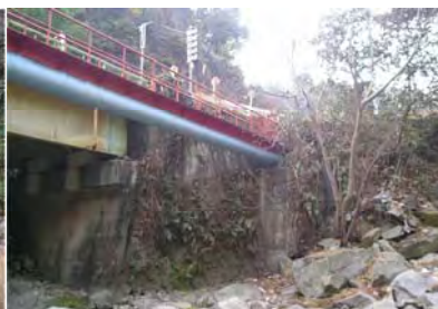
写真－2 C 水管橋
