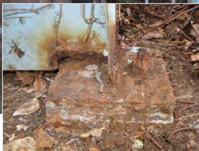
リングサポートの腐食
