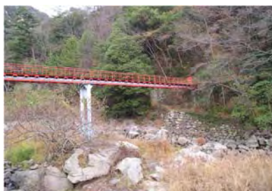
写真－1 B 水管橋
