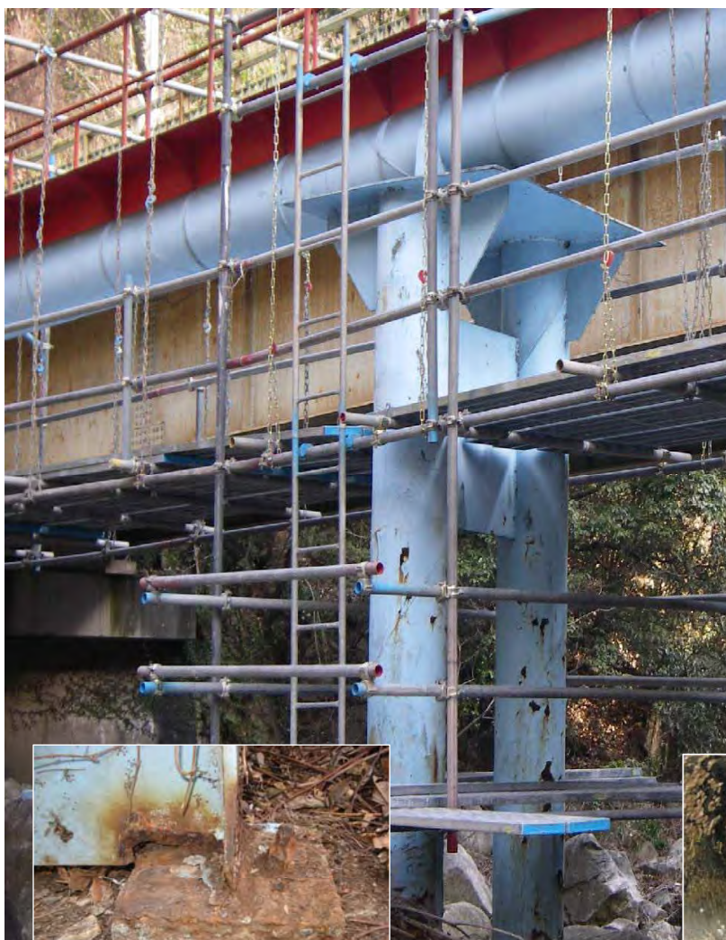
リングサポートの腐食
