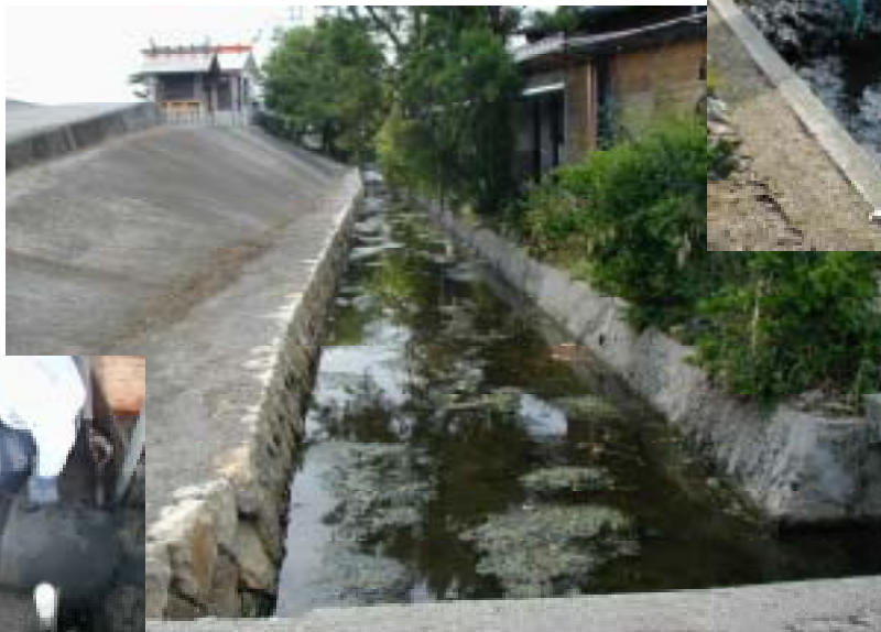
水路下圧送管埋設部
