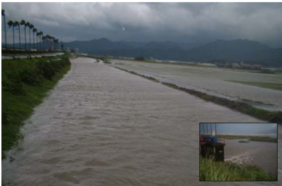
【 台風4号による浸水状況 】
