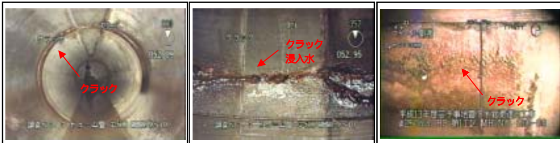
水洗い後の管内部
