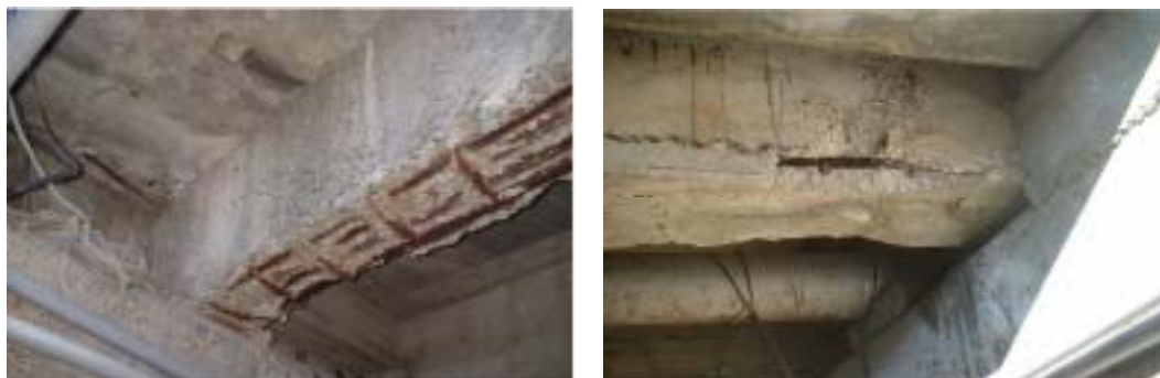
写真 - 1 橋梁の劣化状況
