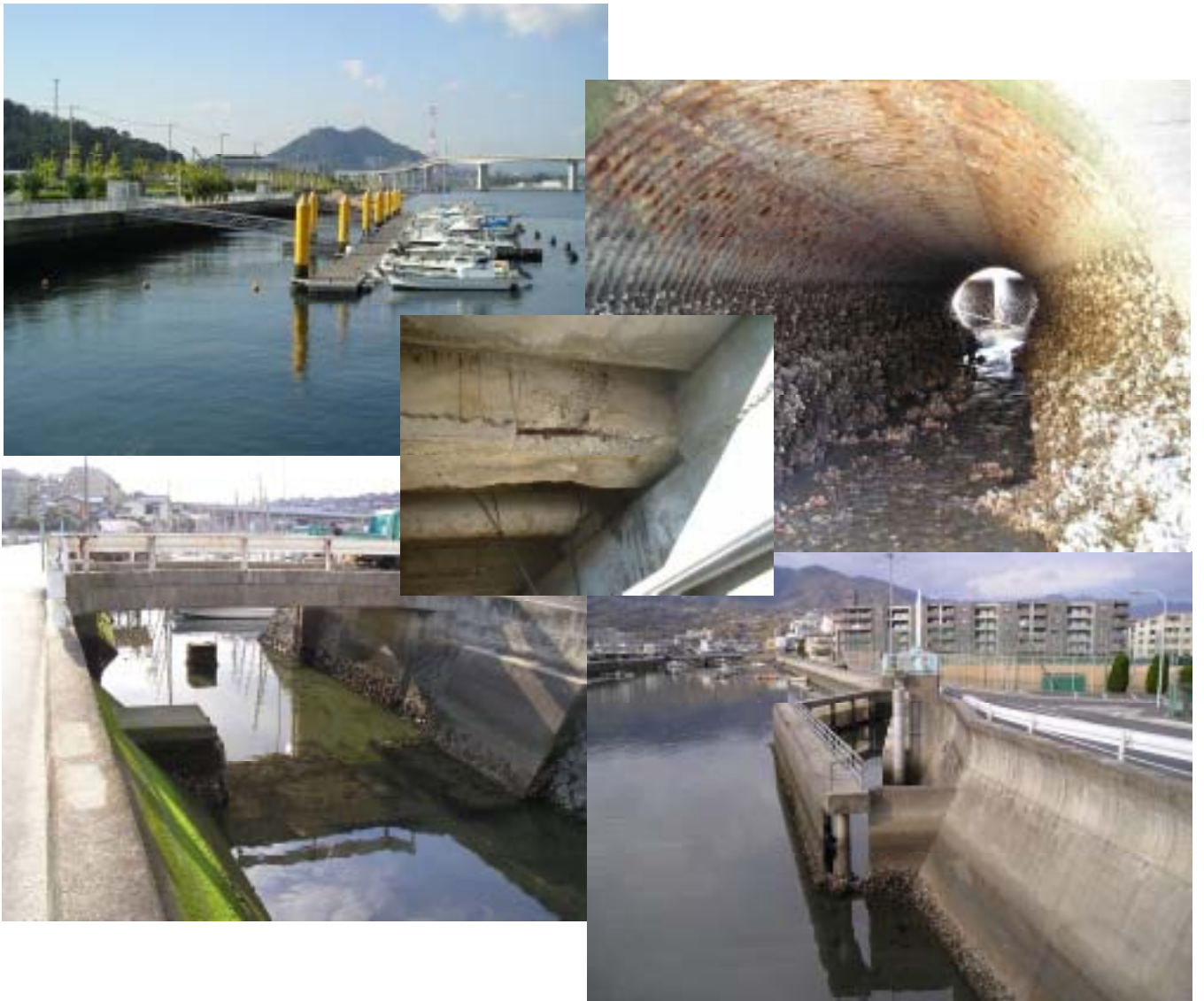
【 沿岸部の構造物 】
